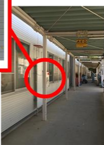
機械科棟通路
