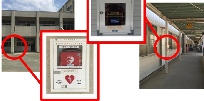
機械科棟通路
