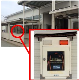
機械科棟通路
